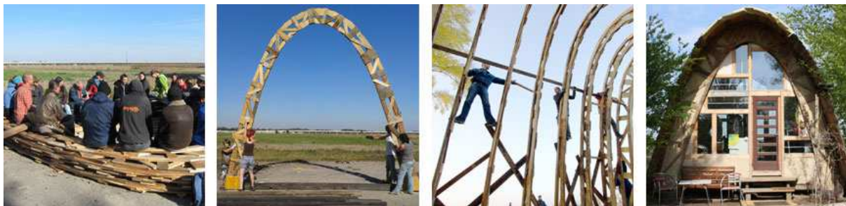
Entstehung des "Kettenlinienhauses" - ein Selbstbaubeispiel auf der tBASE
